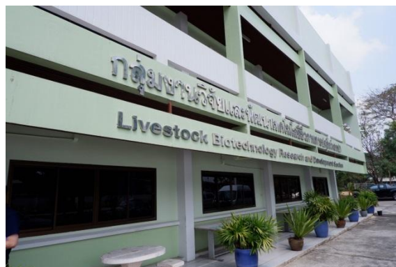
พื้นที่โดยรอบอาคารสะอาด
