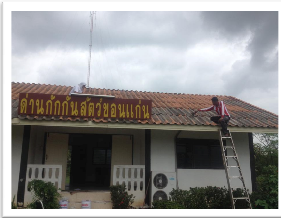
ปรับเปลี่ยนวัสดุทาสีสำนักงาน
