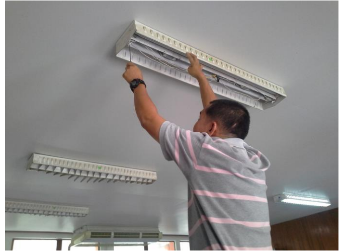
ตรวจสอบและซ่อมแซมอุปกรณ์ไฟฟ้า ทุก ๓ เดือน
