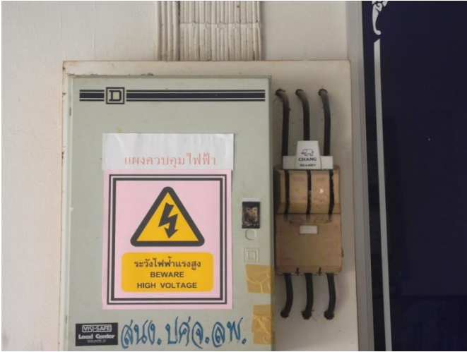
จัดทำป้ายเตือนอันตรายแผงควบคุมไฟฟ้า
